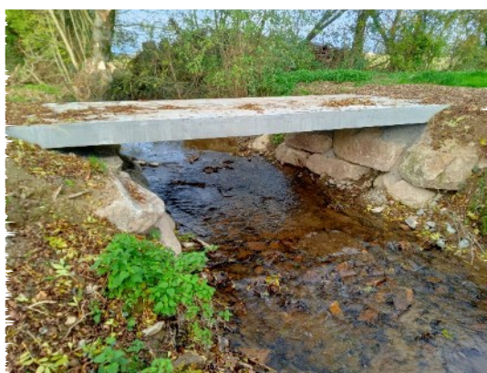
Installation d'une passerelle à la place d'une buse
